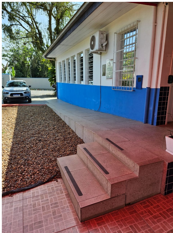
Figura 2 - Escada de acesso à escola cujos degraus deverão ser regularizados.
